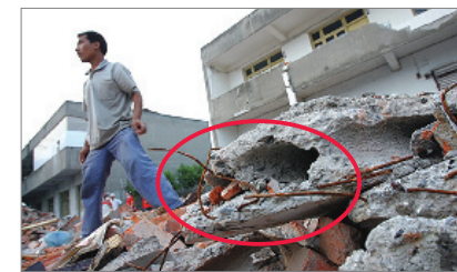
四川地震学校的建筑梁柱为空心水泥、钢筋竟是“细铁丝”
